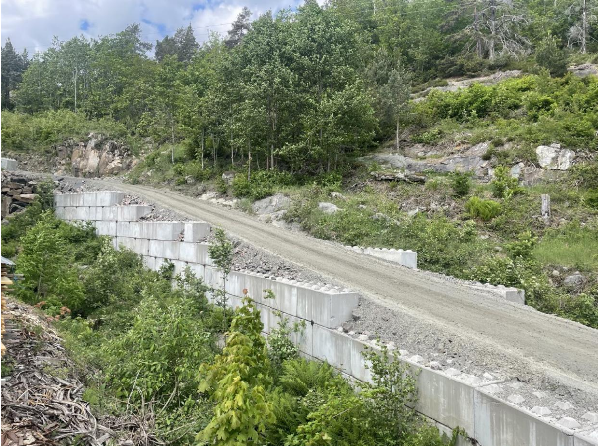
Figur 7 Bilde av tiltak med betongblokker for å minimere inngrep i bevaringszone
